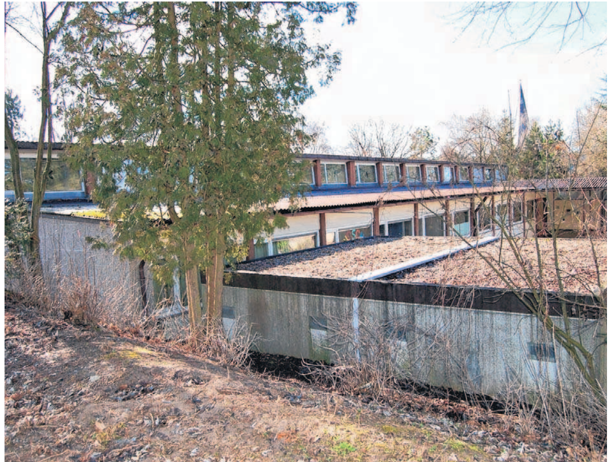
Der Technische Ausschuss stimmte der Planung für die Sanierung der Grundschule Impfingen und der Turnhalle zu. Rund zwei Millionen Euro wird das Projekt kosten. BILD: SEYBOLD
